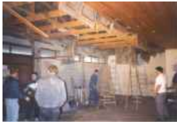
Beginn der Abbrucharbeiten
