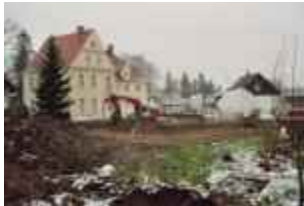
Beginn der Baggerarbeiten
