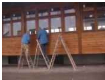
Endspurt an das Außenfassade
